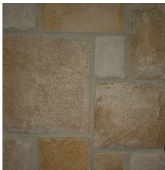
CASTILLO SANTA MARÍA colocación con junta de 1 cm.
